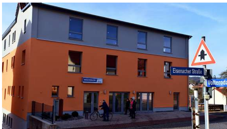
Die Arbeiten für den Umbau des alten Gasthauses Zur Linde in der Eisenacher Straße 24 in Ifta startete die Firma Treyße im April 2018.
